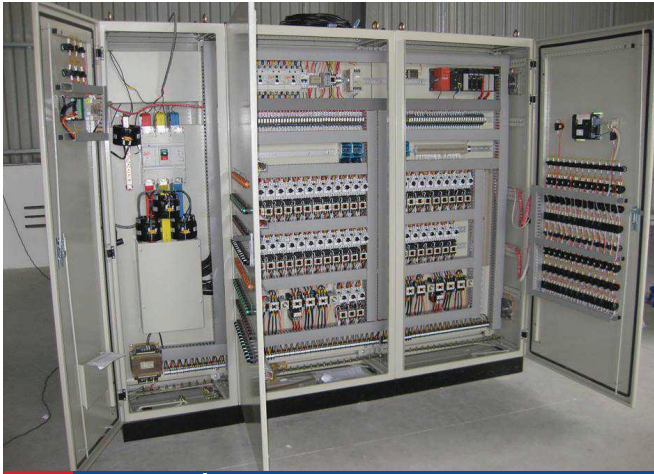
01 Dự án lắp đặt hệ thống tủ điện nhà máy sản xuất
