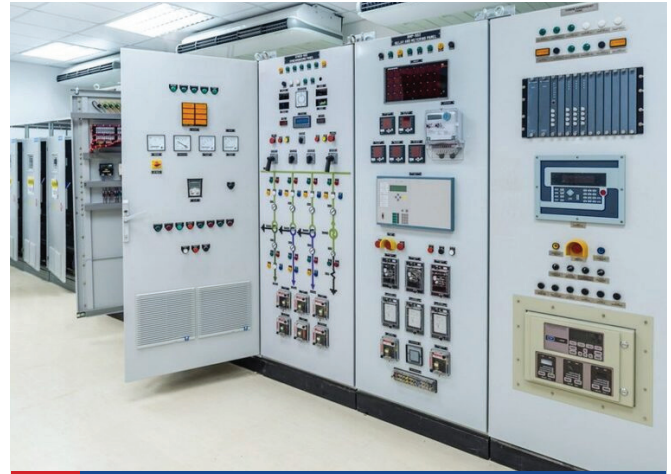
02 Dự án thi công hệ thống điện khu công nghiệp
