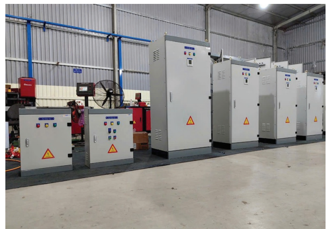
06 Dự án lắp ráp hệ thống tủ điện công nghiệp
