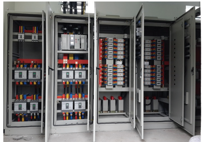
04 Dự án cung cấp và lắp đặt tủ điện phân phối
